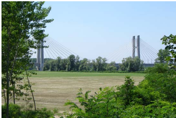
Figura 3 – Il ponte sul Po dell'AV/AC
