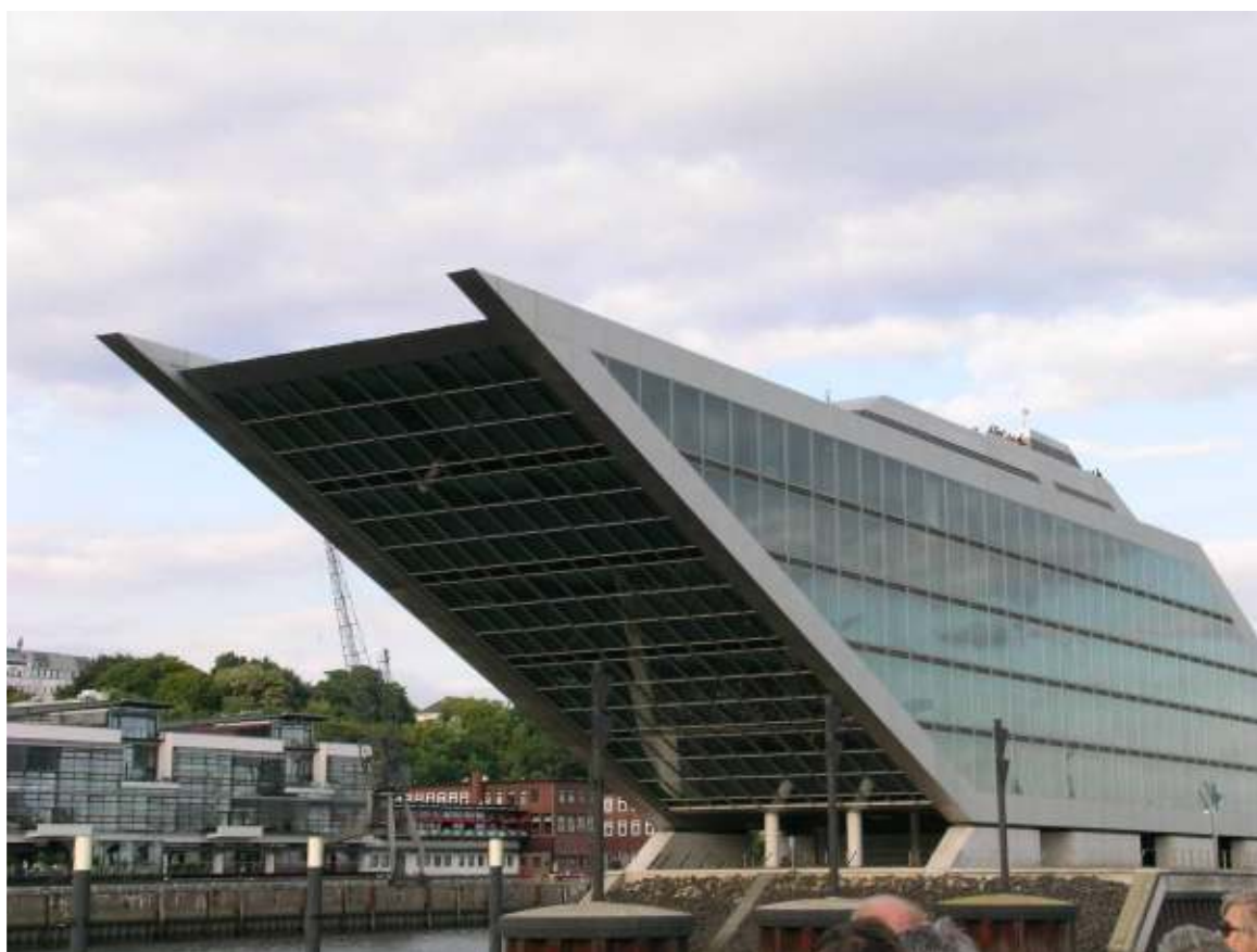
Figura 10 - Docklands, Office building (foto dell'autrice)
